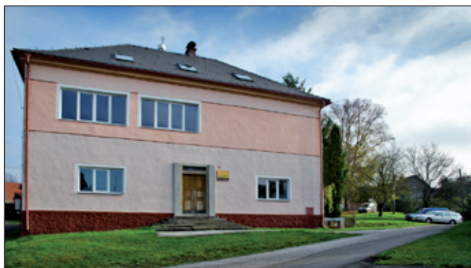
Budova bývalé školy - dnes strojní obrábění.
