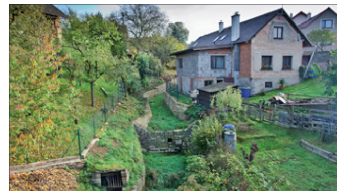
Upravené koryto potůčku odvádějícího vodu z polí nad Vrchovinami v případě přívalových dešťů bezpečně mimo obydlí.
