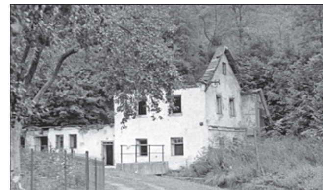
Klopotov vpravo Herzigova barevna 1965. Kanalizace potoka u Herzigovy barvírny 1965. Býv.mlýn a pila Jiřího Štaudy 1979.
