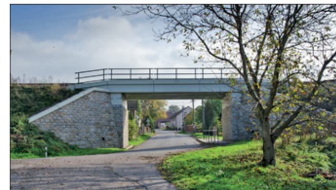
Nový podjezd pod trať na výjezdu k Šonovu - Provodovu a České Skalici.
