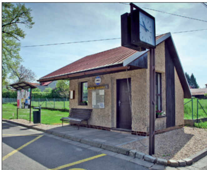
Vkusně provedená autobusová zastávka.
