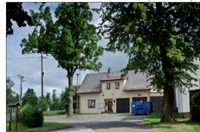
Obecní úřad Dobřany a hasičská zbrojnice.
