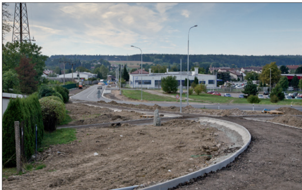
Pohled do Náchodské ulice od mostu u Ammannu - dodělává se cyklostezka a záhony.
