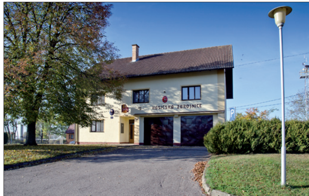
Obecní úřad, hasičská zbrojnice a základna s plzeňským?
