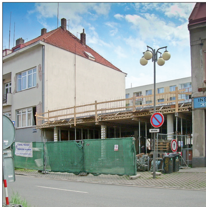
Výstavba vietnamského víceúčelového zařízení rovněž jede naplno.
