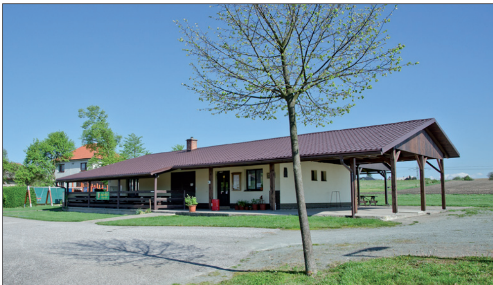
Víceúčelové zařízení „Na Ohrádce“.
