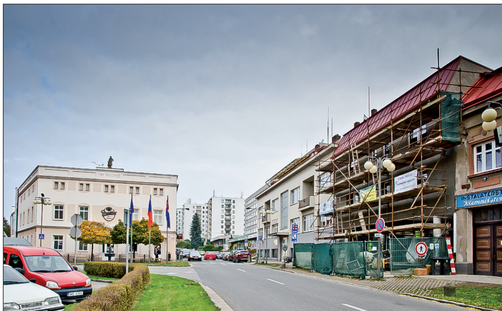
Výstavba nového domu v prostoru u Rychty. Vedle stav tohoto místa v různých dobách v minulosti.
