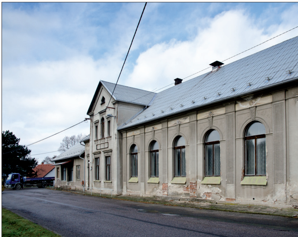
Objekt výstavné hospody v Záhornici, vzadu je vidět přístavba prodejny. Dnes z toho nic není v provozu.
