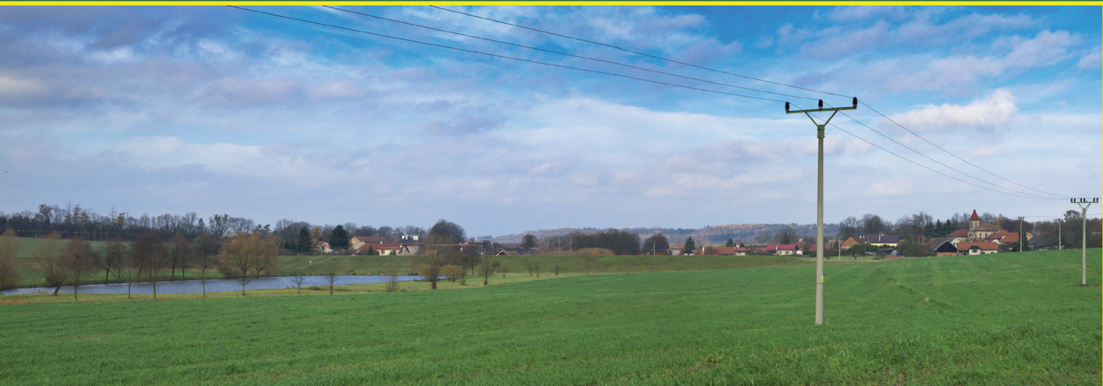
Obec Trnov s pěkně zhotoveným poldrem nad obcí. Foto: J.B.
