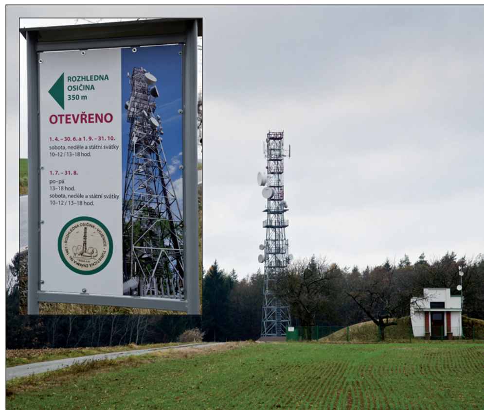
Rozhledna OSIČINA nad Záhornicí a také vodojem pro ten vytoužený vodovod.
