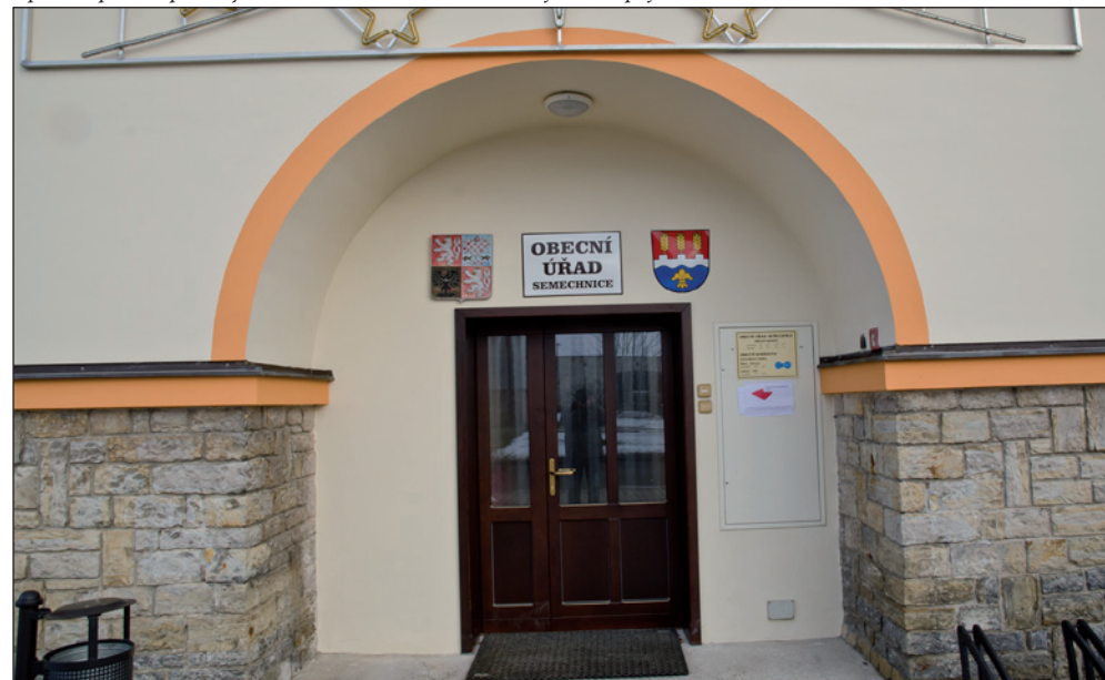
Opravdu pěkně upravený vchod do Obecního úřadu. Tam jistě vstupují občané s radostí.
