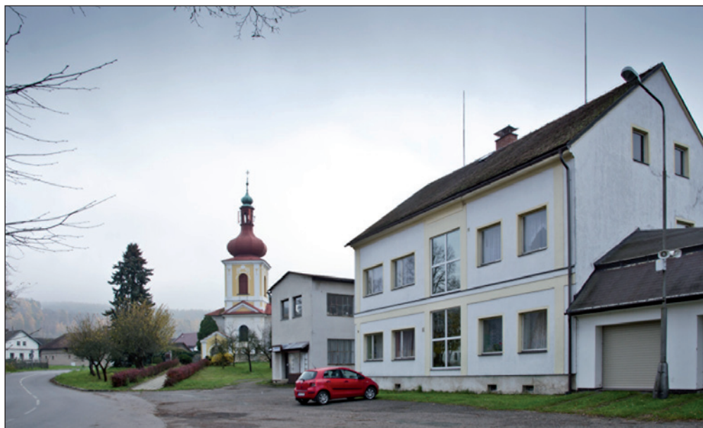
Křivice - pohled na část návsi - místní strojírenský podnik.
