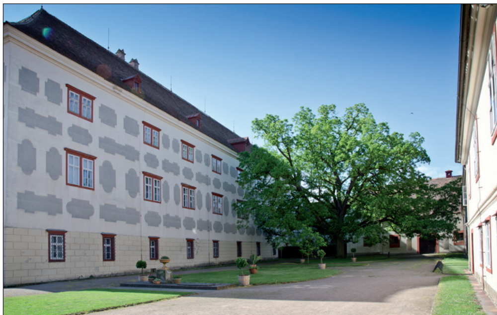
Opocno - vedlejší budovy s jízdárnou, vlevo zadní trakt zámku.
